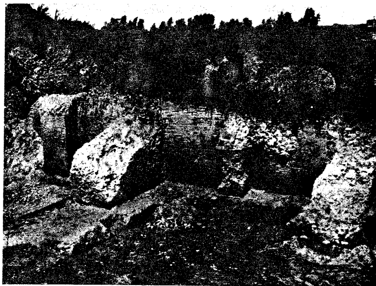
Fig. 79 - Pilastrì e contrafforti dei magazzini n. 54.
