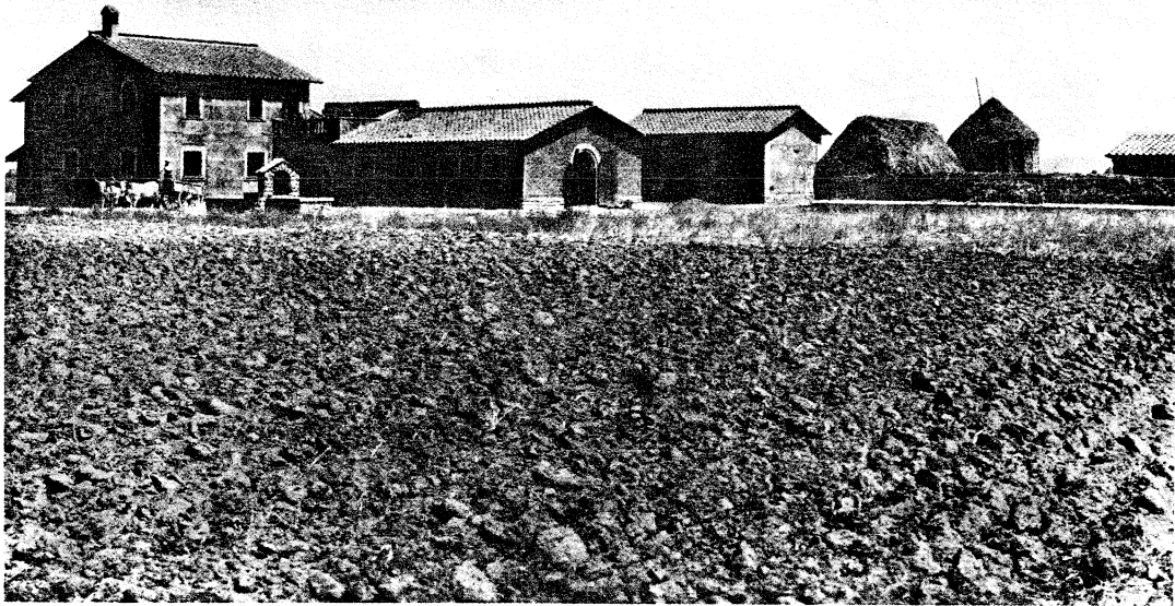
Fig. 117 - Podere approntato per l'inizio della conduzione a colonia.
