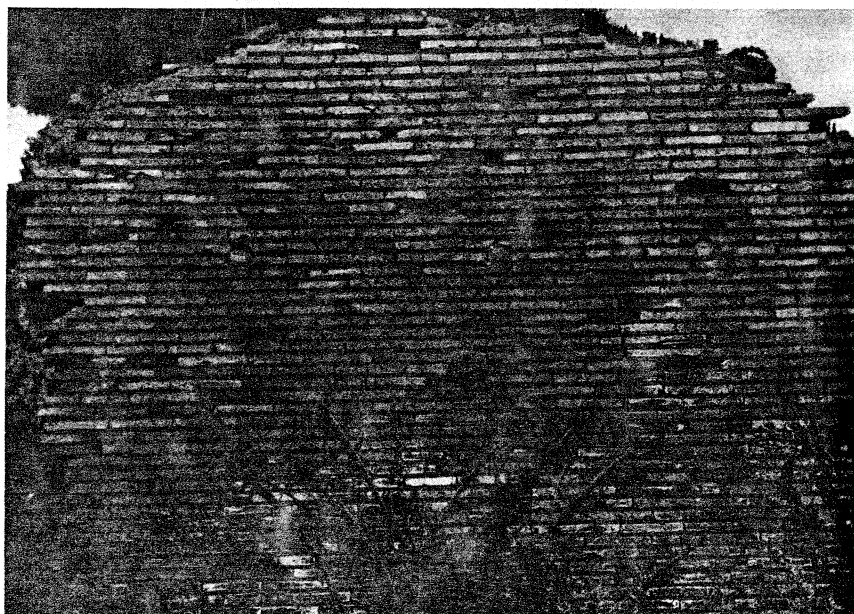
Fig. 58 - Particolare della cortina laterizia d'età severiana ( Horrea n. 18).
