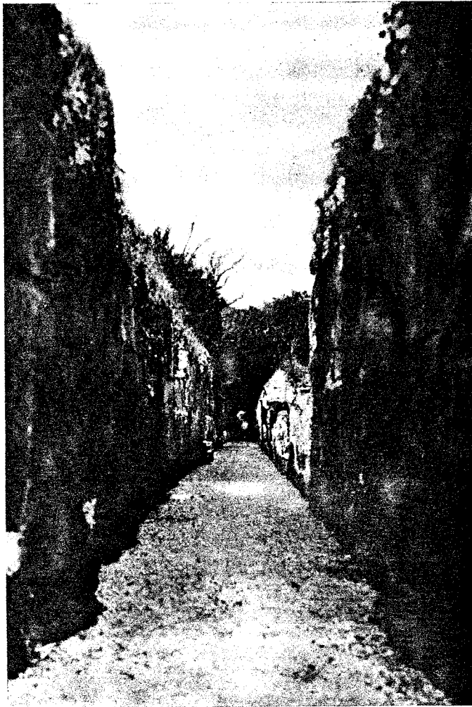
Fig. 53 - Corridoio di servizio dietro la terrazza di Traiano (n. 12).
