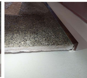
Fig. 5: Dettaglio dello spessore del supporto in cemento e della staffa metallica di sostegno
