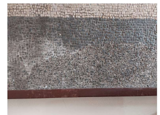
Fig. 8: Integrazione delle lacune del tessellato effettuate con tessere della stessa cromia dell'originale ma di forma irregolare.
