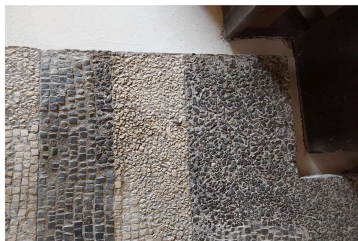
Fig. 4: Particolare dell'adattamento del mosaico alla scala: si noti il taglio del manufatto effettuato nella zona restaurata, come si evince dalla diversa tipologia delle tessere
