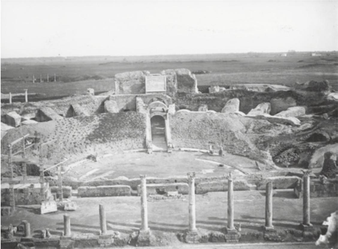
Fig. 8. Ostia, teatro, la cavea alla fine degli interventi di scavo. 1913. Negativo alla gelatina, cm 12,9 x 17,8. AF SBAO, neg. B 2090. Gli archi dei setti sostruttivi della cavea appaiono restaurati; il ponteggio di legno sulla sinistra è in uso per rialzare sul muro a blocchi della scena le cornici in marmo trovate durante lo scavo, visibili appoggiate a terra
