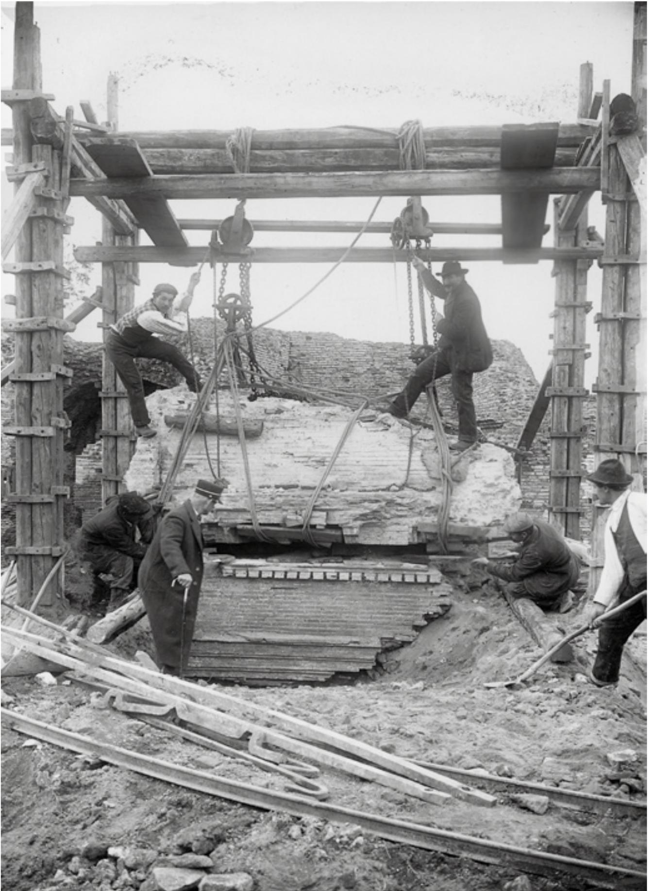
Fig. 10. Ostia, teatro, operazioni di sollevamento di blocchi di muratura crollati. Dicembre 1912. Negativo alla gelatina, cm 12,9 x 17,8. AF SBAO, neg. B 2060. «Si sollevarono due grandi blocchi del prim'ordine [i.e. del portico] che stavano negli scarichi lungo la via delle Corporazioni» (D. Vaglieri cit., in GRECO 1997-1998, p. 75). I due grandi frammenti, ricongiunti, sono ancora oggi visibili sulla strada a est del teatro
