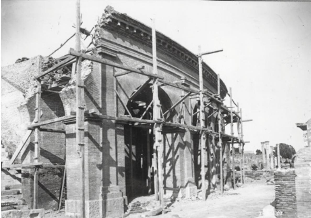
Fig. 37. Omero Visca (?). Ostia, l'ambulacro esterno del teatro visto da sud-ovest. 1° ottobre 1939. Negativo alla gelatina, cm 12,8 x 17,8. AF SBAO, neg. B 2885. A sei mesi dall'inizio dei lavori il prospetto esterno è ricostruito nella sua parte centrale, comprese le modanature architettoniche basate su frammenti originali crollati; si procede quindi alla costruzione della volta di copertura dell'ambulacro
